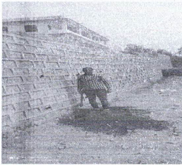
कालिका भूमे संरक्षण वाल निर्माण
